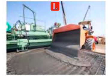
図1 UHPFRCを打設している状況(実証実験)
