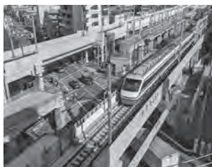
高架になった上り急行線 (写真:足立区提供 吉田ビル撮影協力)
