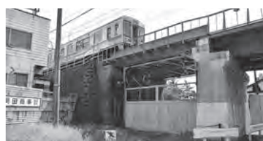
北千住駅～牛田駅の間にはかつて旧貨物線の2本の引き込み線があり、1本は岡田商事千住工場の引き込み線で、現在もレールが残っています。上は京成本線（撮影：高橋茂仁）
