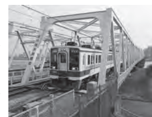
荒川橋梁を走る6050系（撮影：高橋茂仁）
