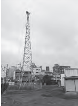
足立区東六月町にあるニッポン放送足立予備送信所
